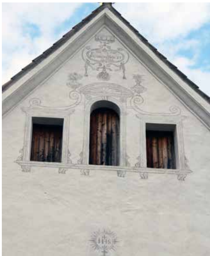
Detailansicht der Westfassade mit dem Sgraffitodekor nach der Restaurierung
