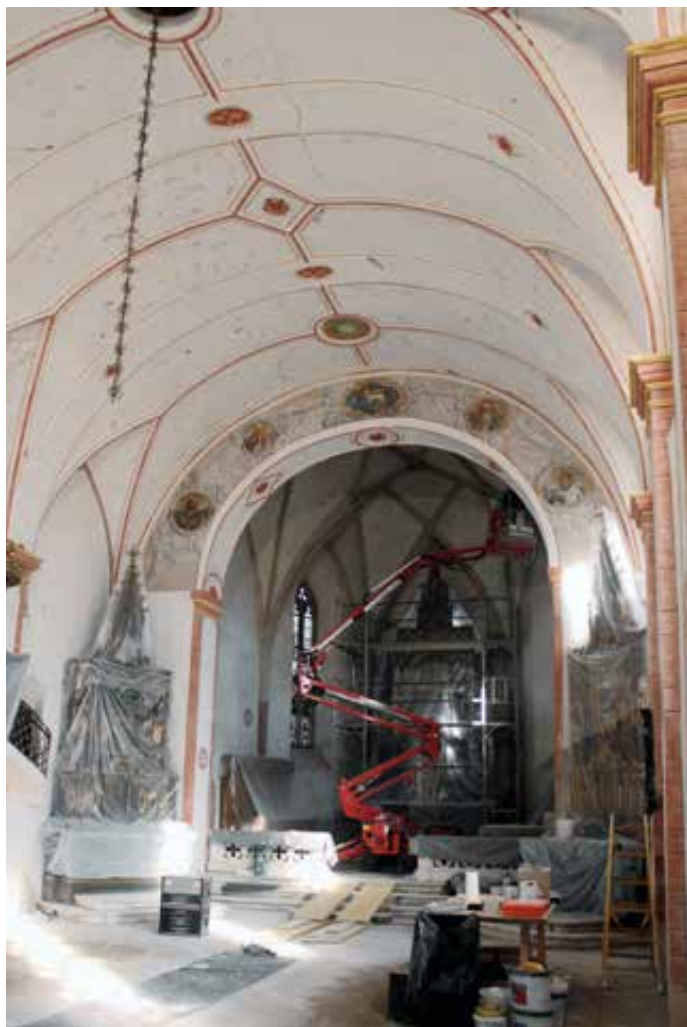
Der Innenraum wurde über eine Hebebühne gereinigt
