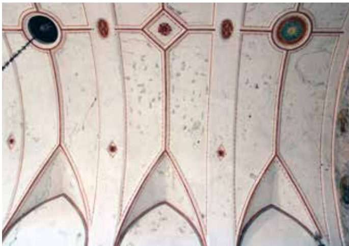
Detailansicht des Langhausgewölbes nach der Reinigung im Februar dieses Jahres
