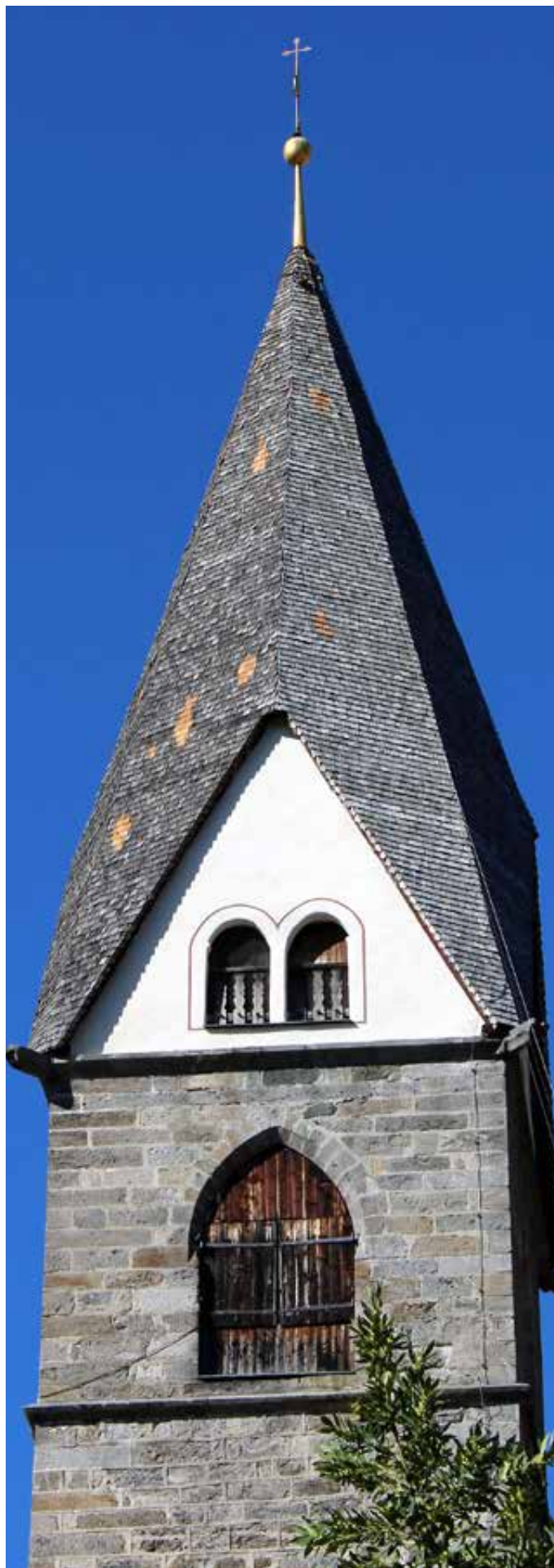
Der Turmhelm nach der punktuellen Neueindeckung und der Restaurierung der Frankengiebel im Frühjahr dieses Jahres
